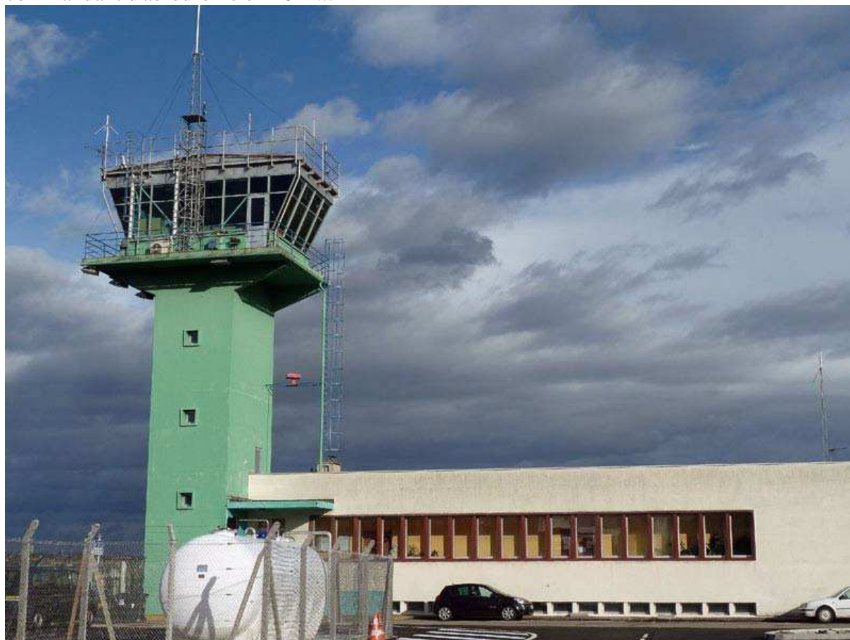
Nouveau bloc technique construit en 1969
