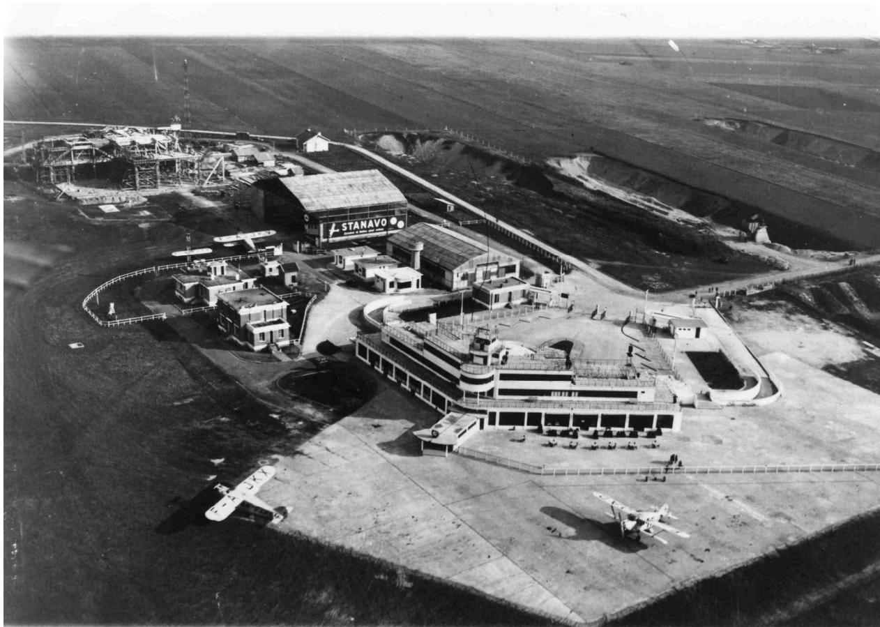
Photo aérienne du Port aérien de Lyon – Bron, avec en arrière-plan la construction du hangar Caquot
