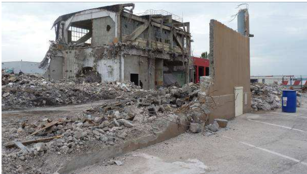
Le hangar Caquot de Bron au cours de l'été 2012
