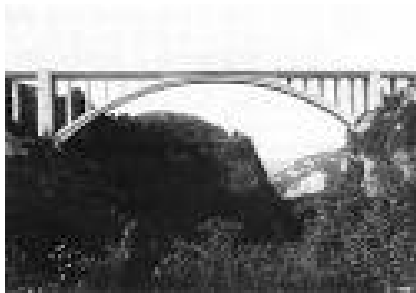
Pont des Usses
