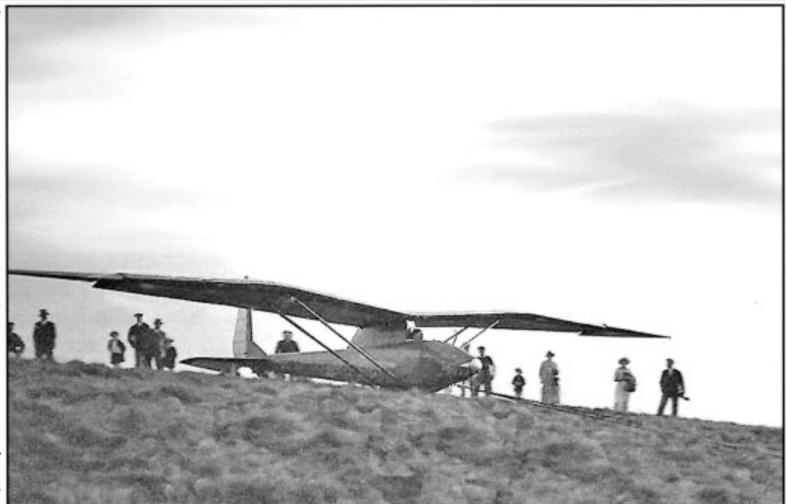
*sur une cabane carénée située derrière le poste de pilotage et contreventée au fuselage par deux paires de mâts parallèles.»*
